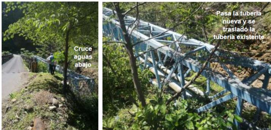
Figura 7. Paso sobre el río Colorado. Fuente: Visita técnica al proyecto, junio 2020.
