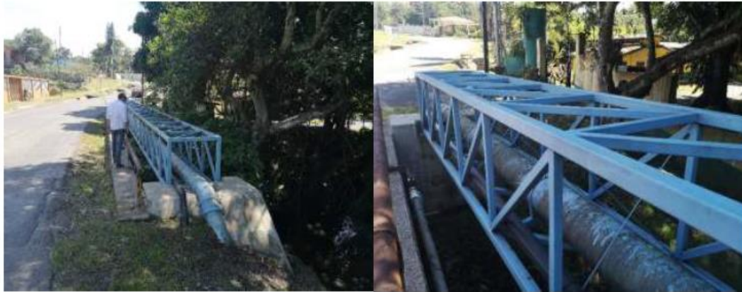
Figura 10. Paso sobre el río Cajón. Fuente: Visita técnica al proyecto, junio 2020.
